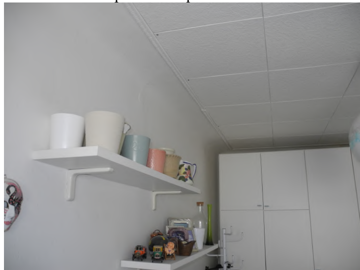
FOTO 37 – soffitto stanza laterale; pannelli di polistirolo
