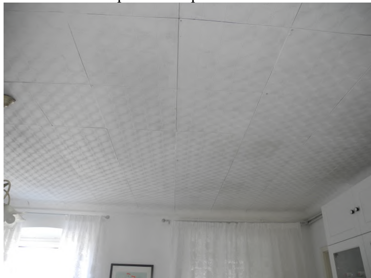
FOTO 34 – soffitto stanza centrale/soggiorno; pannelli di polistirolo
