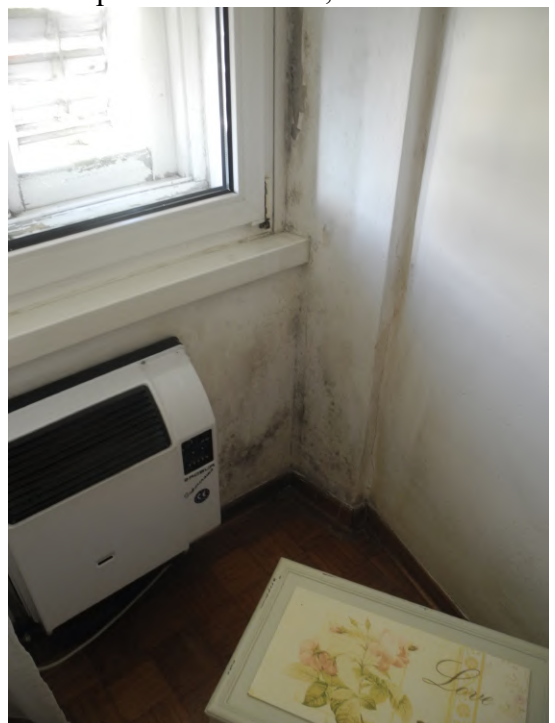
FOTO 42 – camera matrimoniale; convettore per riscaldamento; umidità da condensa
