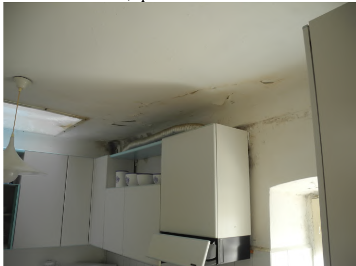
FOTO 30 – cucina; spandimenti/infiltrazioni a soffitto
