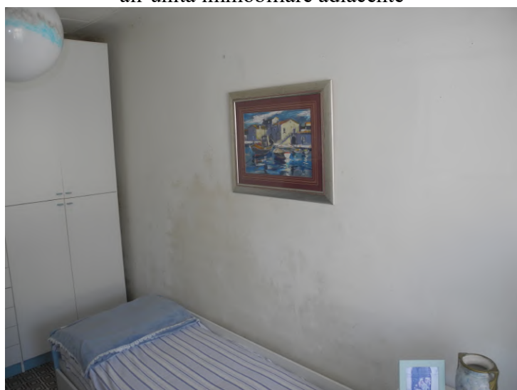
FOTO 36 – stanza laterale; umidità da condensa su muro di separazione rispetto all'unità immobiliare adiacente
