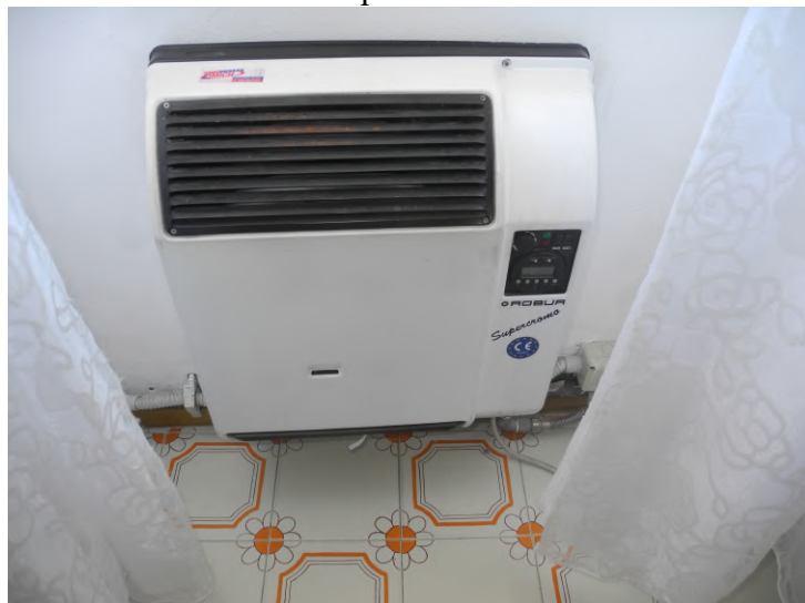
FOTO 35 – stanza centrale/soggiorno; convettore per riscaldamento
